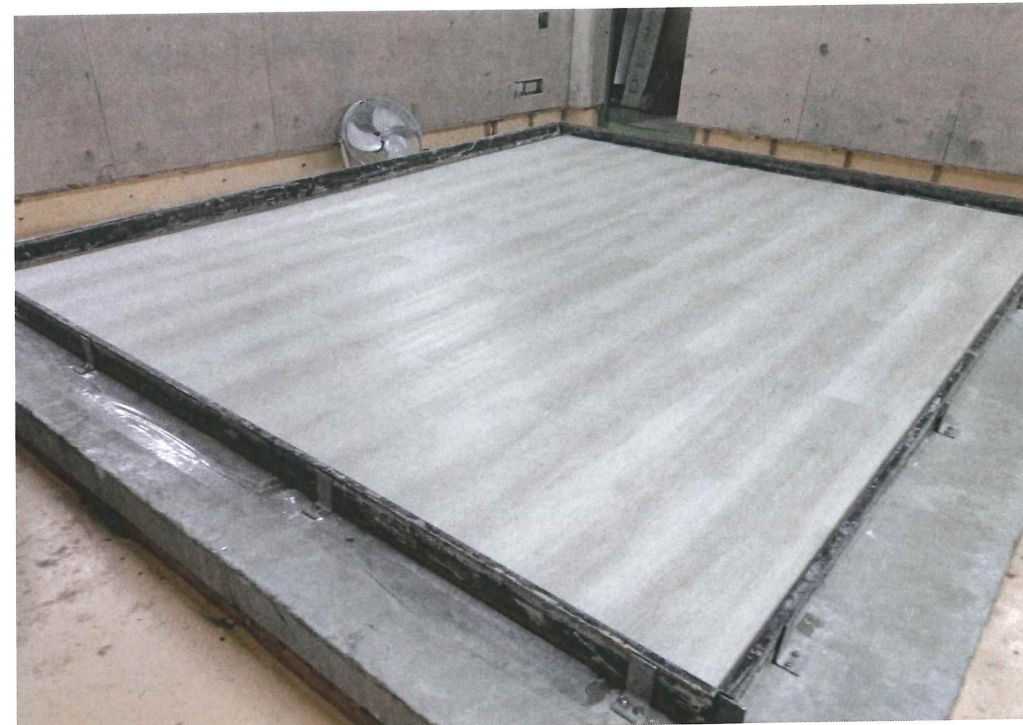
圖6.4 試件施工完成
