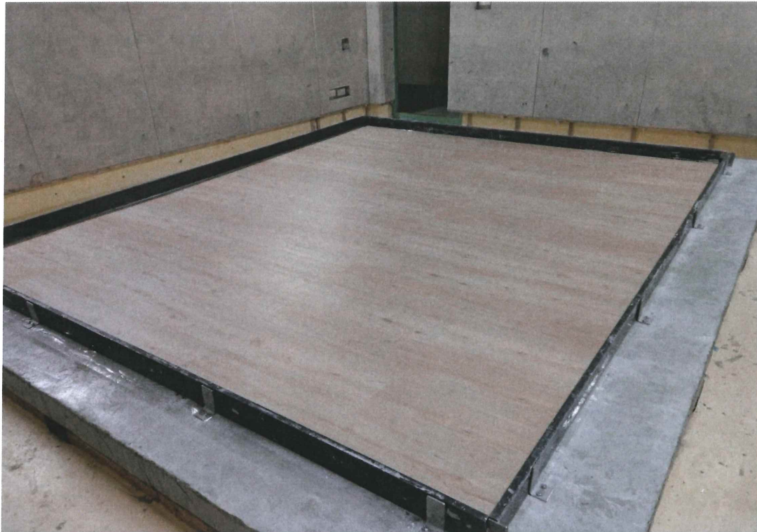
圖6.4 試件施工完成
